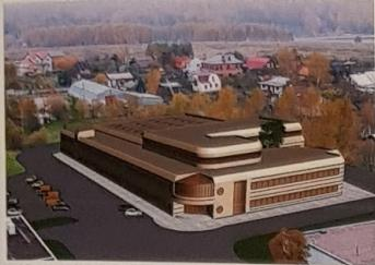
помещений и световыми фонарями над основными залами. Диспетчерские залы ориентированы на северо-восток для защиты от избыточной инсоляции и бликов. В связи с большой глубиной залов предусмотрены световые фонари на покрытии.
